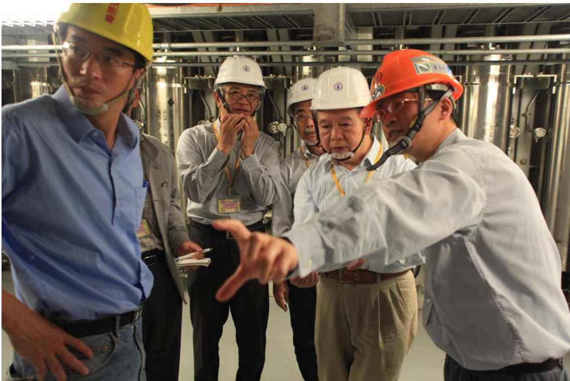
照片 6 (液壓驅動單元) 現場反應器廠房巡視
