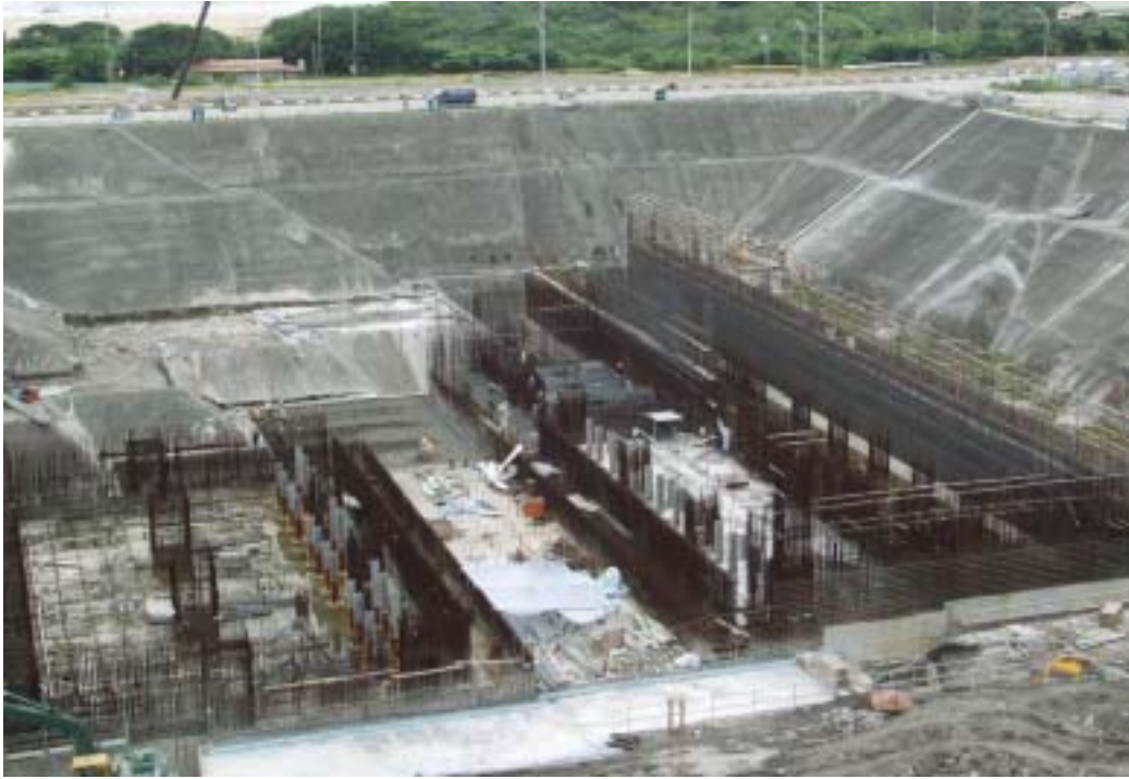
照片五：二號機汽機廠房施工現況
