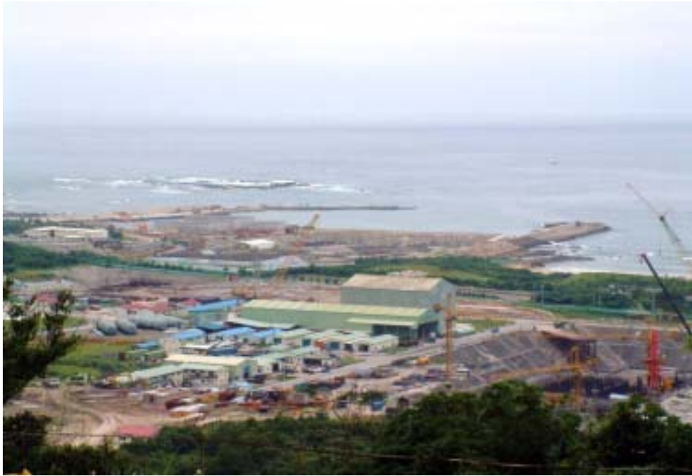
照片九：南北防波堤及重件碼頭施工現況
