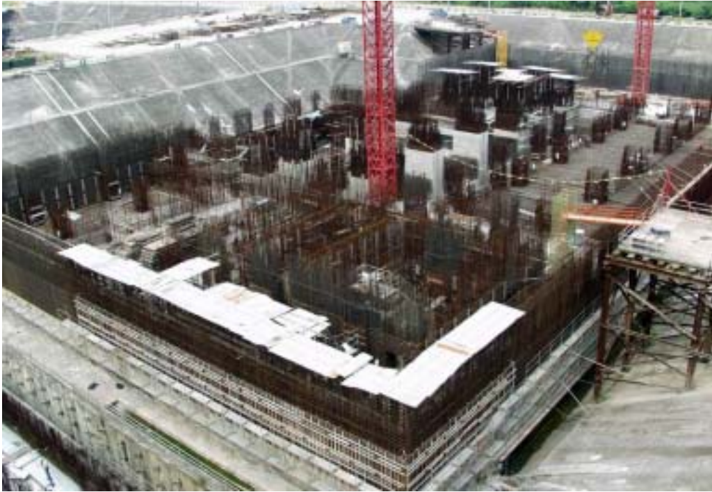
照片三：一號機汽機廠房施工現況
