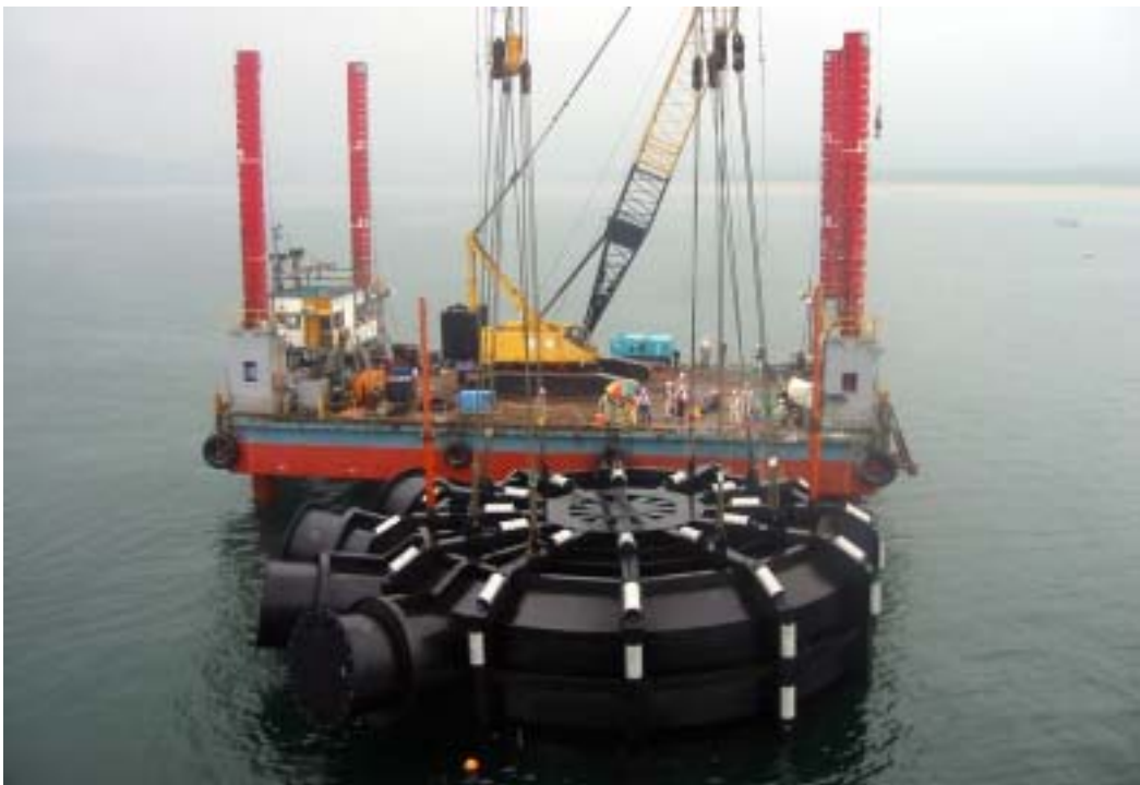
照片六：出水道工程到達井排水頭施工情形
