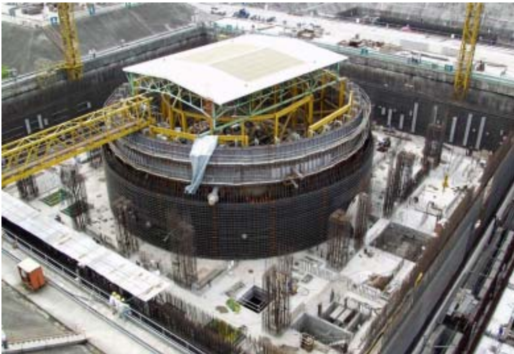
照片二：一號機反應器廠房施工現況
