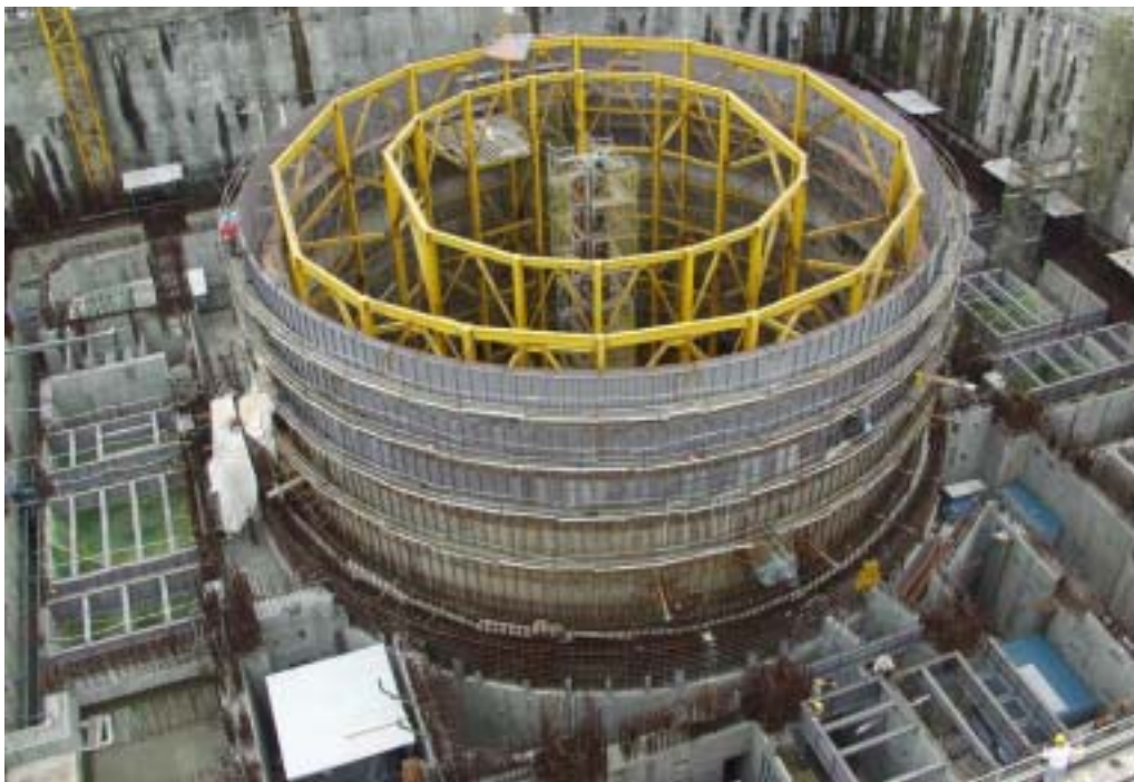
照片四：二號機反應器廠房施工現況
