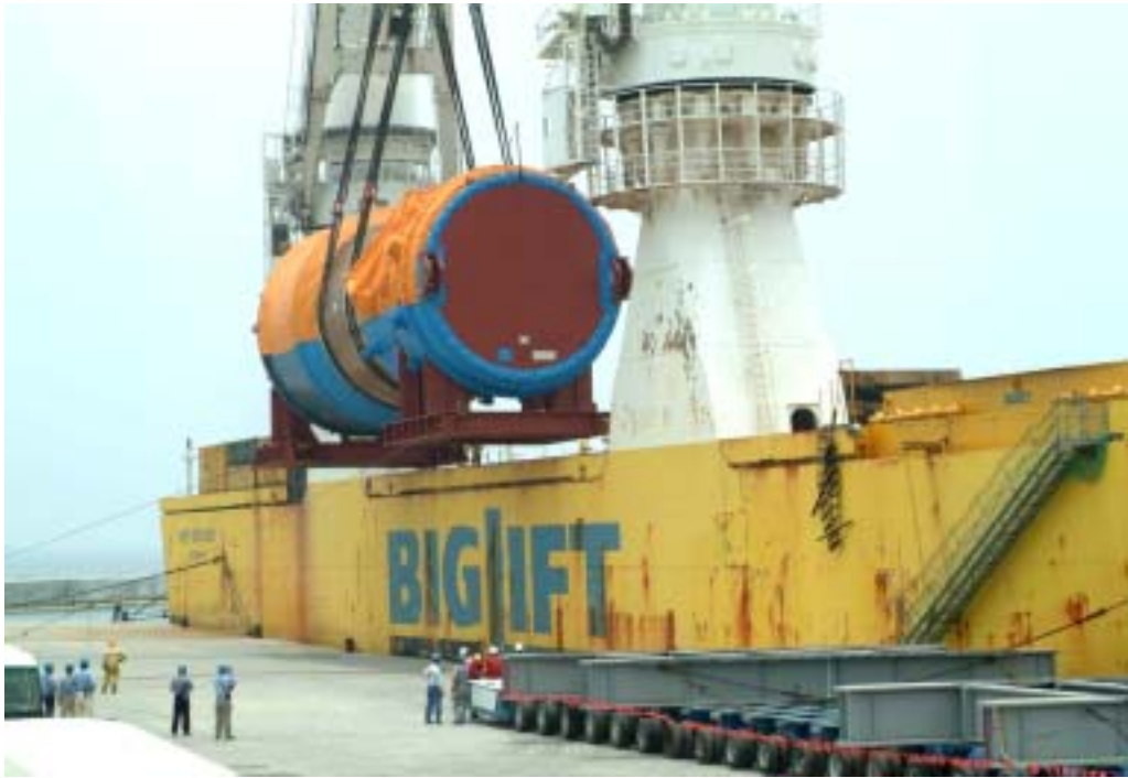
照片七：一號機核反應器吊運情形
