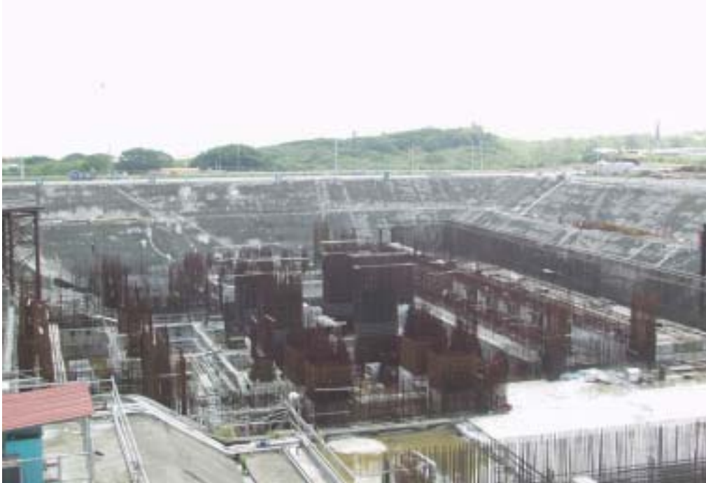
照片七：二號機汽機廠房施工現況
