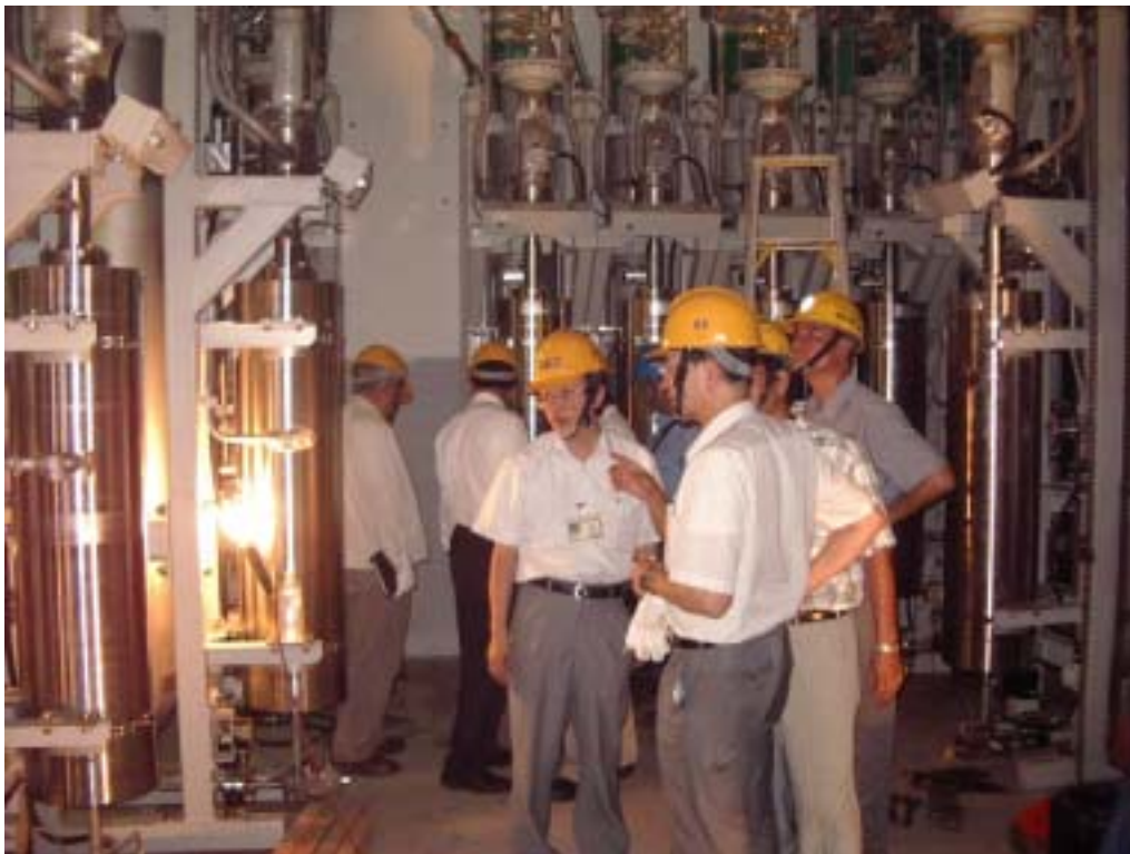
照片十：視察人員巡視一號機 HCU 安裝現場情形
