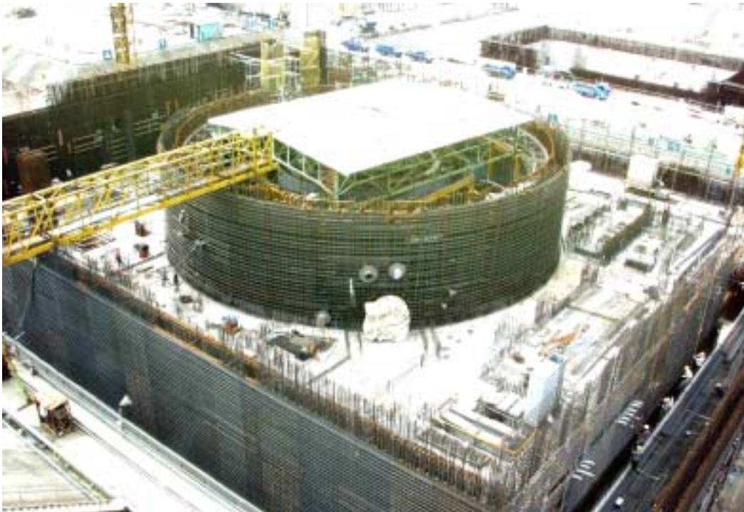
照片二：一號機反應器廠房施工現況
