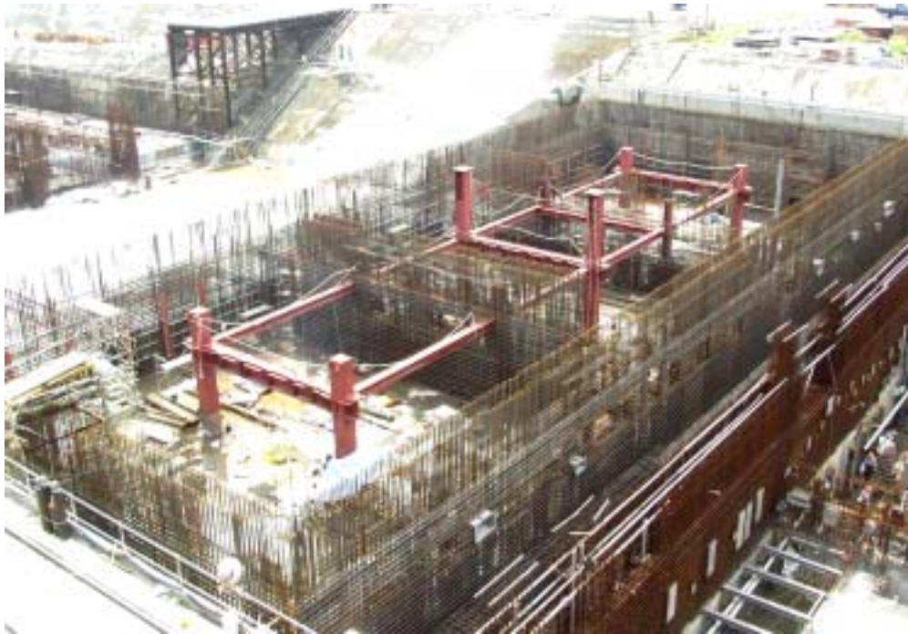
照片六：二號機控制廠房施工現況
