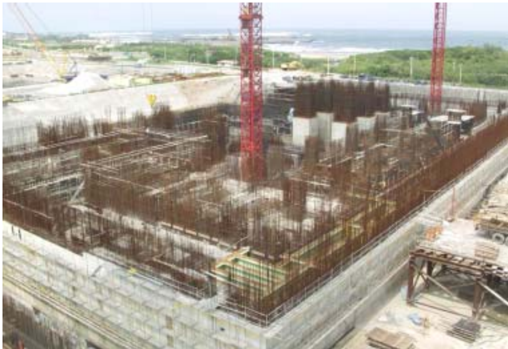
照片四：一號機汽機廠房施工現況
