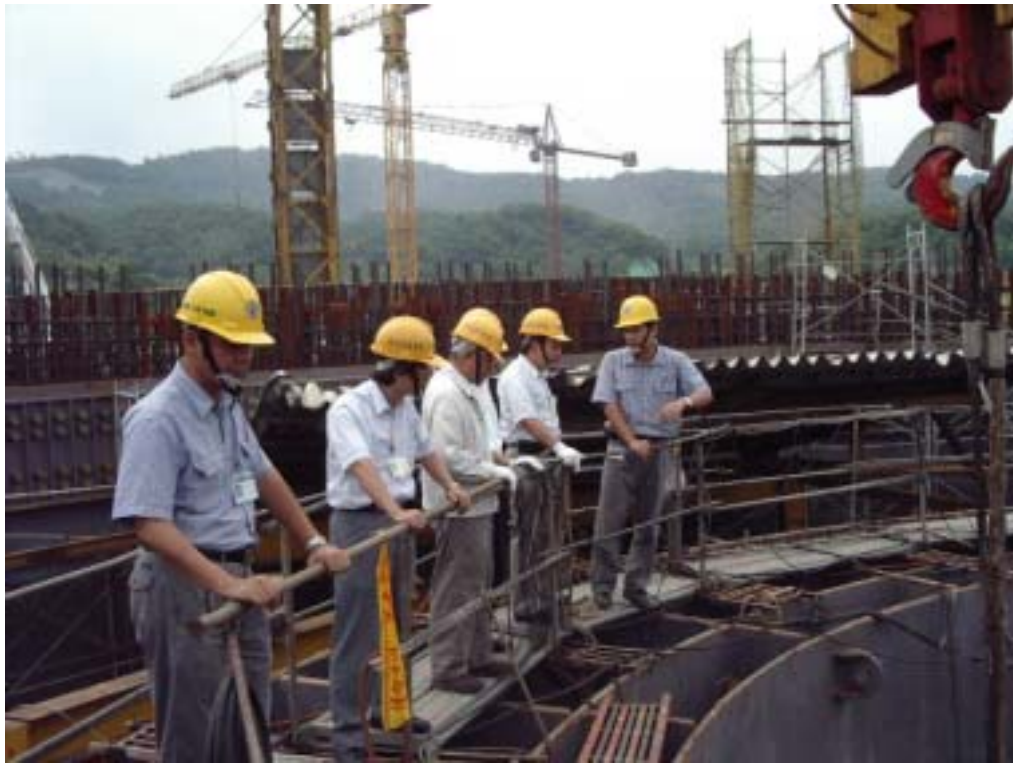
照片十一：視察人員巡視一號機 RPV 基座安裝現場情形
