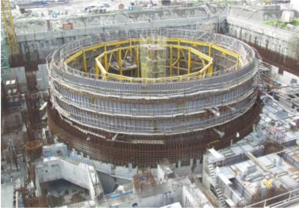
照片五：二號機反應器廠房施工現況
