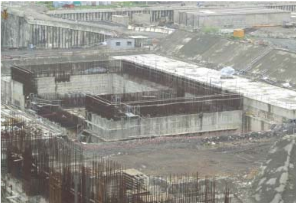
照片八：輔助用過燃料廠房施工現況
