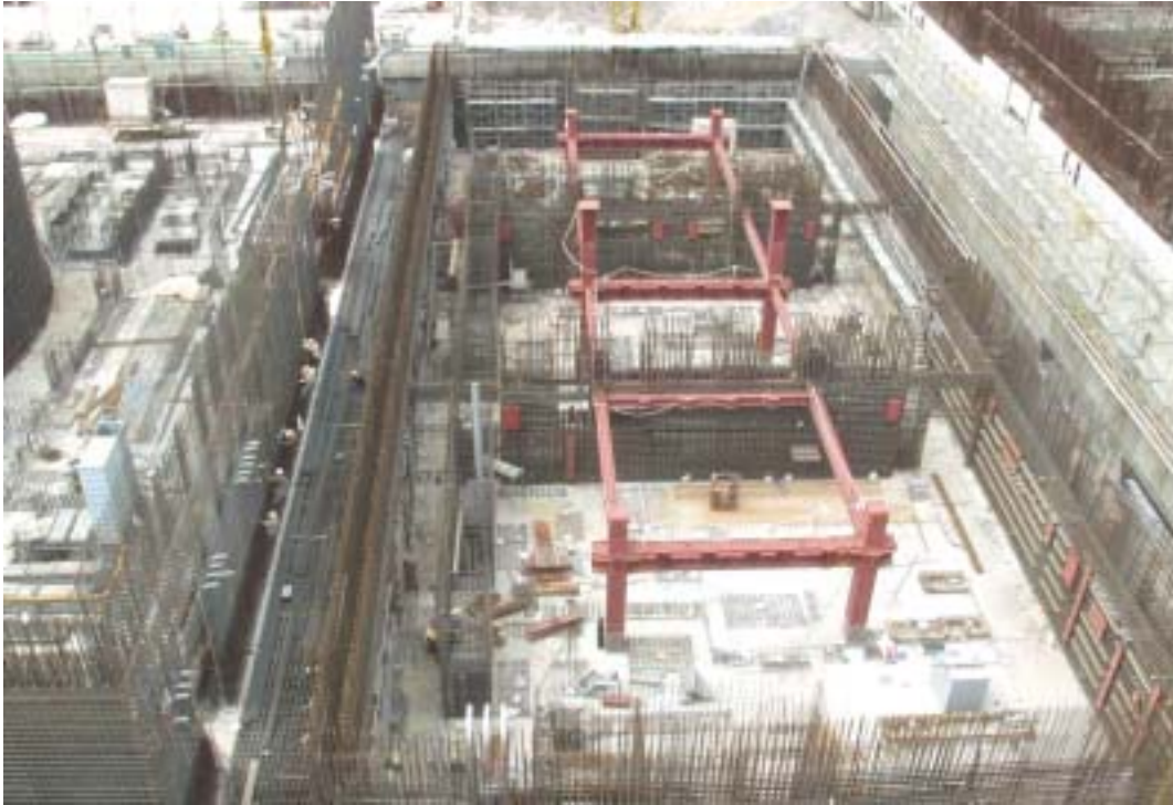
照片三：一號機控制廠房施工現況
