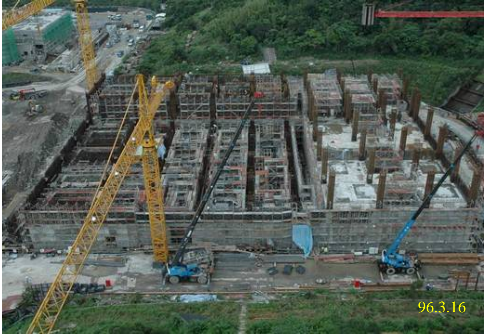
照片五：核廢料廠房施工現況
