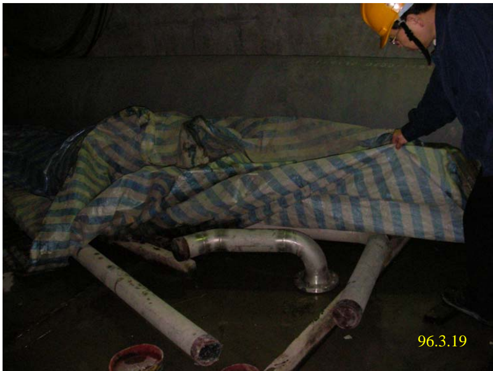
照片八：視察一號機汽機廠房現場管路儲存情形
