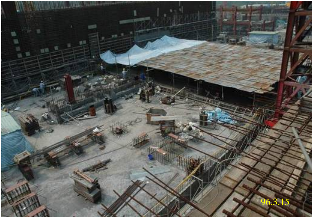
照片三：一號機控制廠房施工現況
