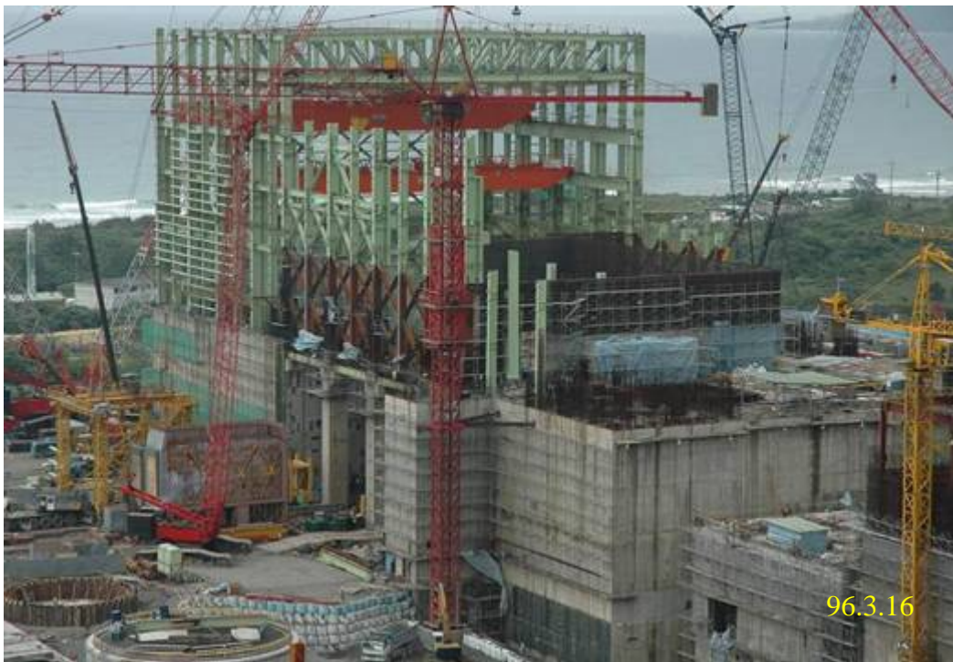
照片四：一號機汽機廠房施工現況
