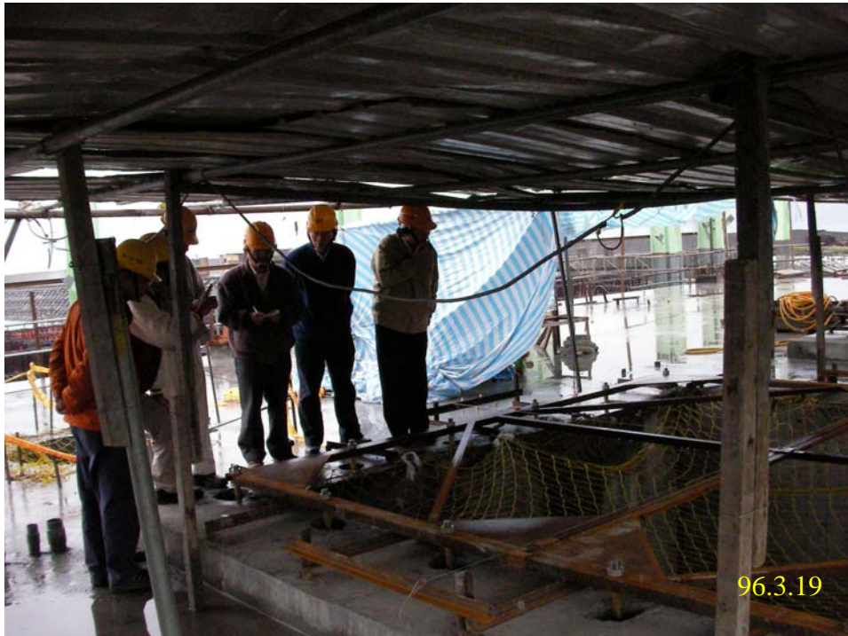
照片九：視察循環冷卻水抽水機房現場情形
