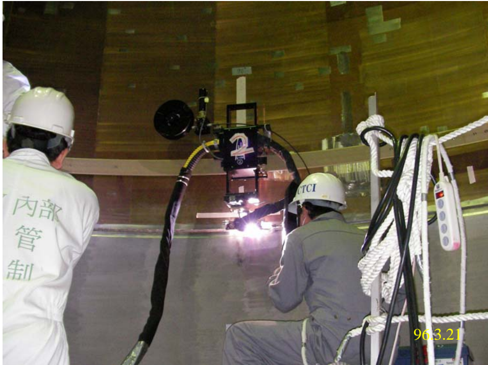
照片七：爐心側鈹銲接作業情形(二)
