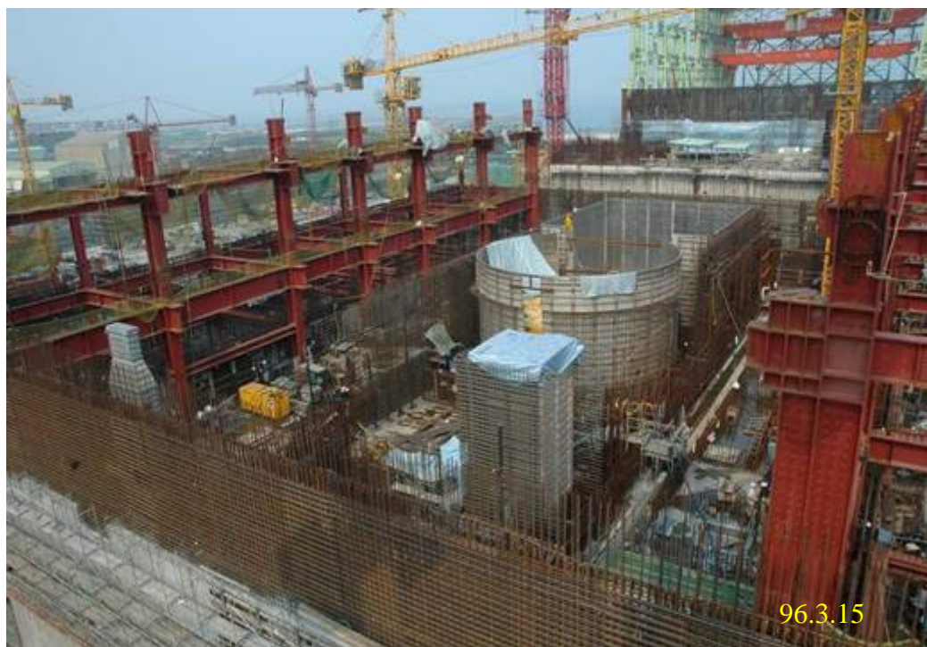
照片二：一號機反應器廠房施工現況
