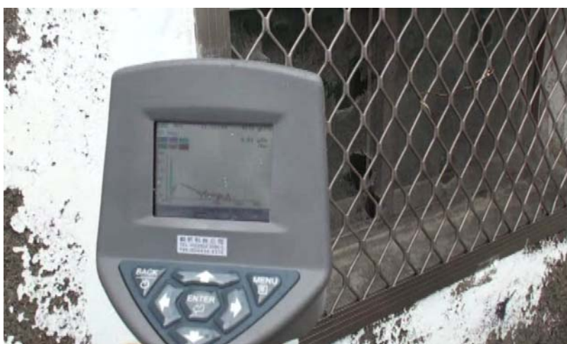
圖六：使用 BNC SAM-940 將探頭朝向舊衛生所牆壁實施偵測， 基地台與儀器間無人體阻擋時顯示 4179 cps
