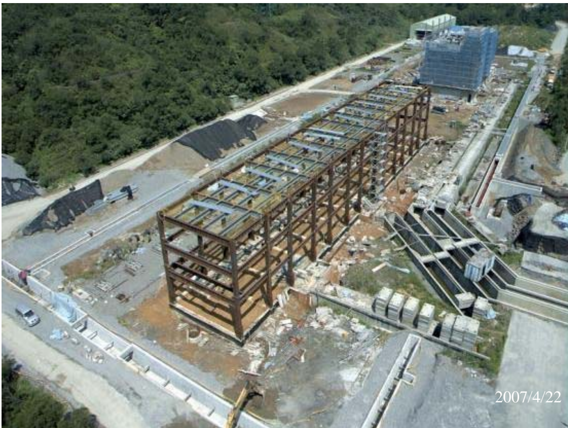
圖八：開關場施工現況圖景
