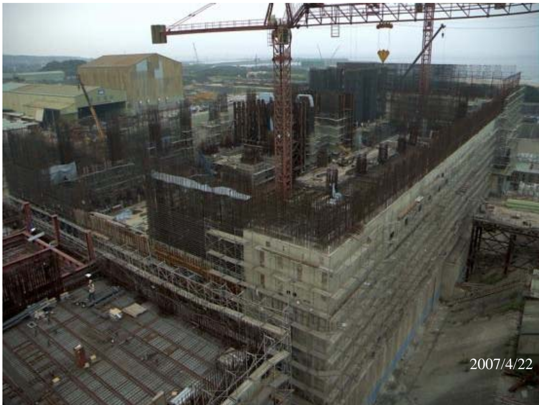
圖六：二號機汽機廠房施工現況圖景
