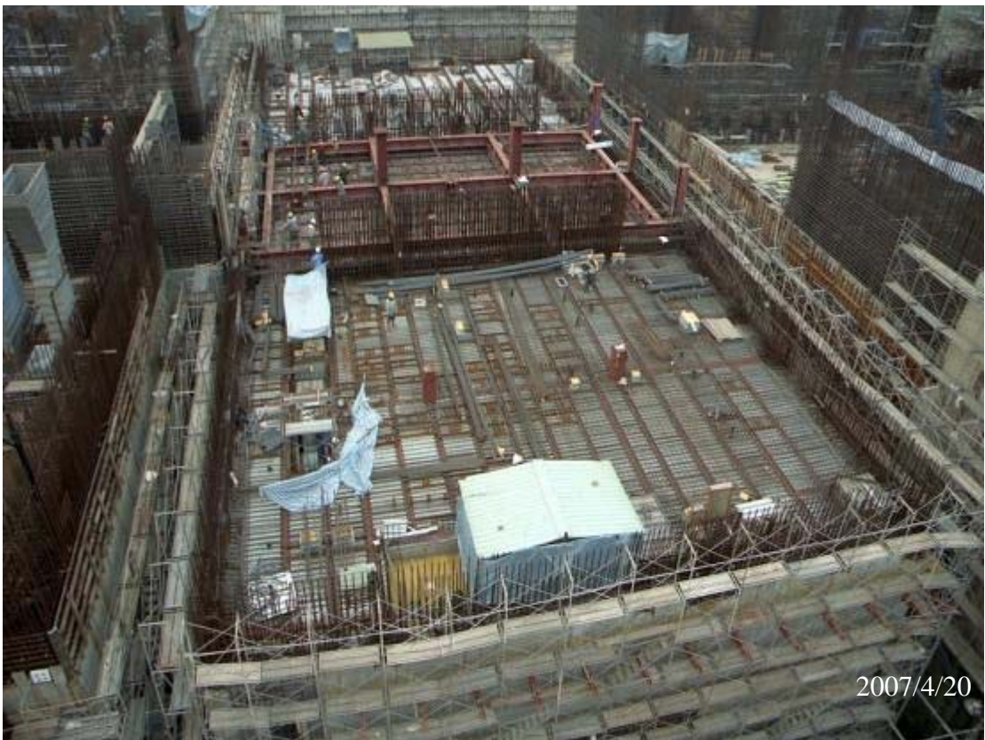
圖四：二號機控制廠房施工現況圖景
