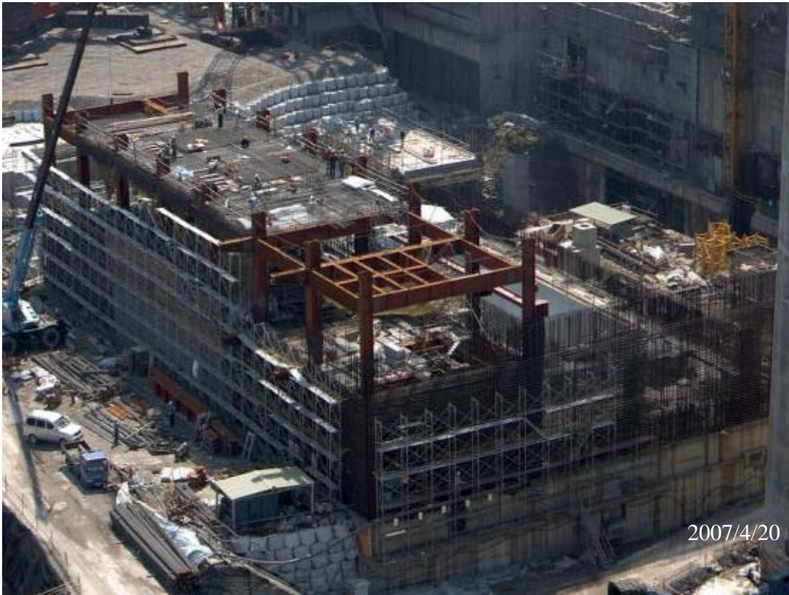
圖七：輔助用過燃料廠房施工現況圖景
