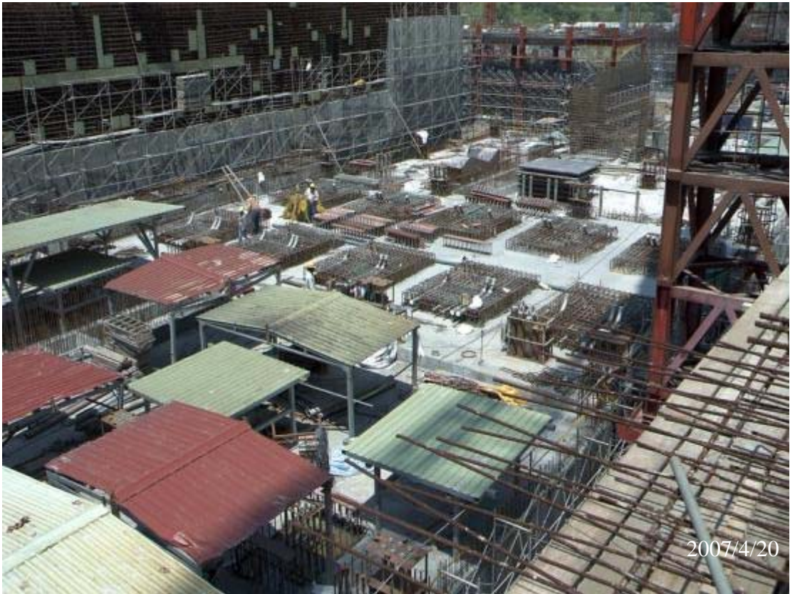
圖三：一號機控制廠房施工現況圖景
