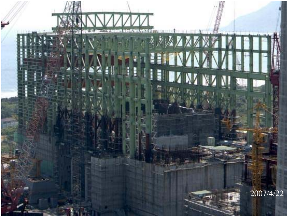
圖五：一號機汽機廠房施工現況圖景
