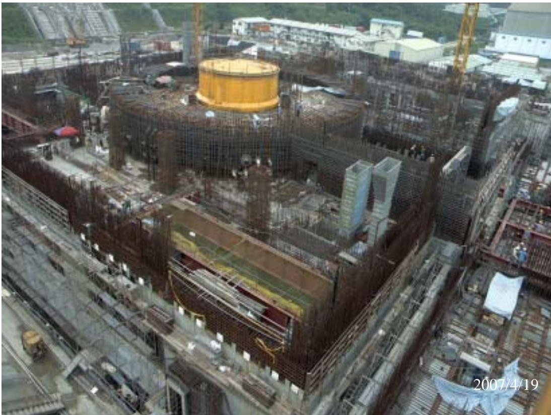
圖二：二號機反應器廠房施工現況圖景
