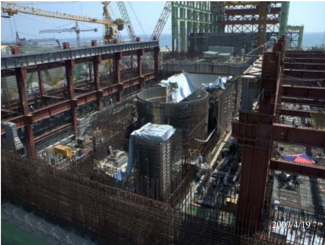
圖一：一號機反應器廠房施工現況圖景
