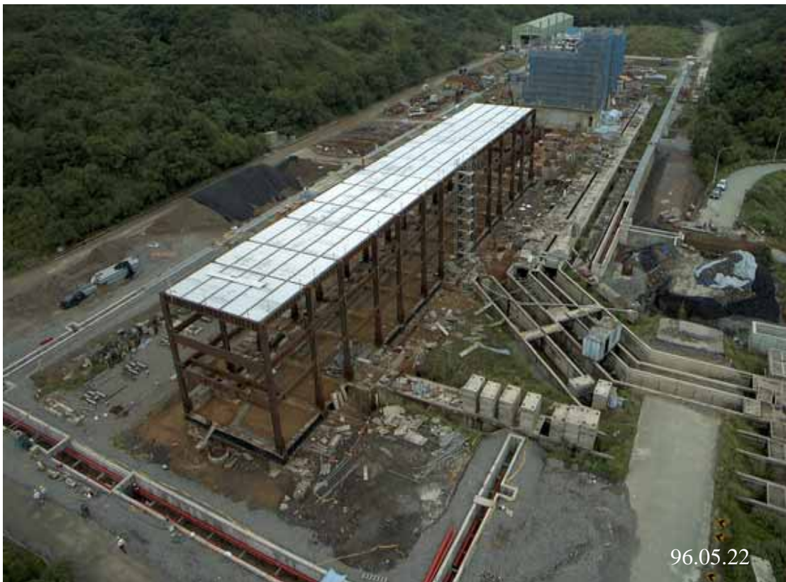
圖八：開關廠施工現況圖景
