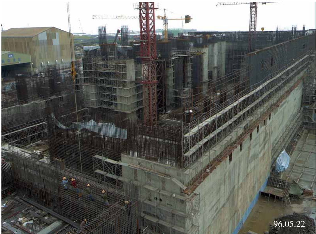
圖六：二號機汽機廠房施工現況圖景
