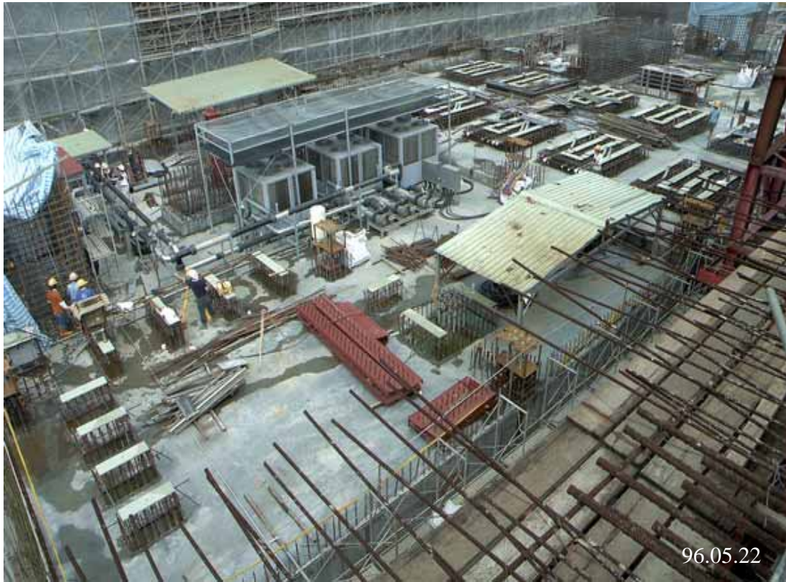
圖三：一號機控制廠房施工現況圖景
