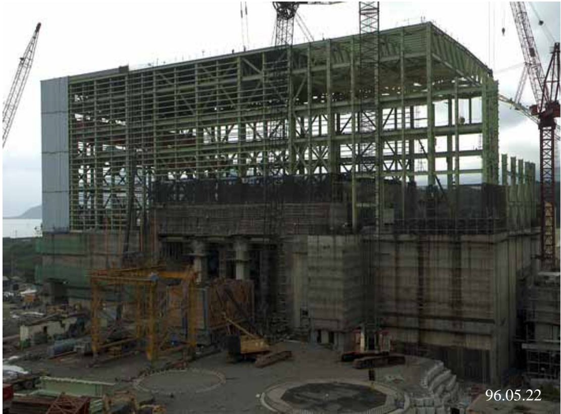
圖五：一號機汽機廠房施工現況圖景
