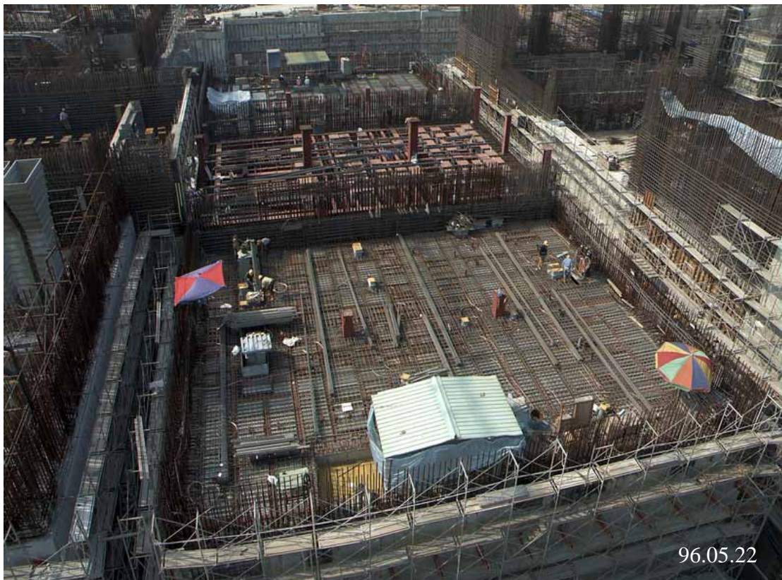
圖四：二號機控制廠房施工現況圖景
