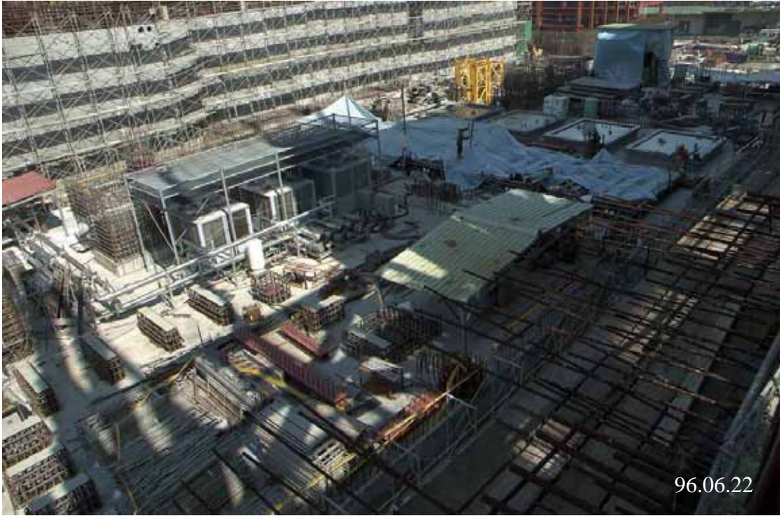
圖三：一號機控制廠房施工現況圖景
