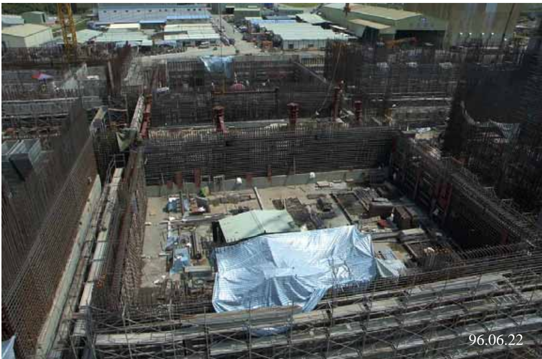
圖四：二號機控制廠房施工現況圖景
