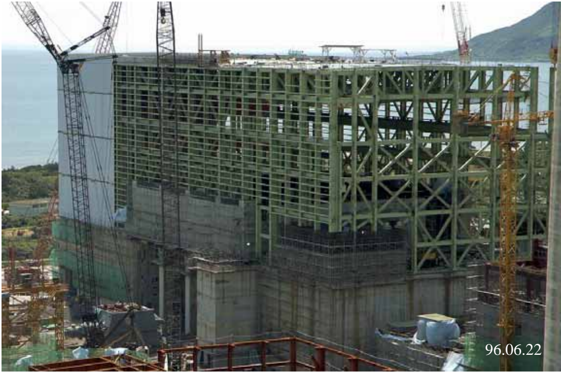
圖五：一號機汽機廠房施工現況圖景
