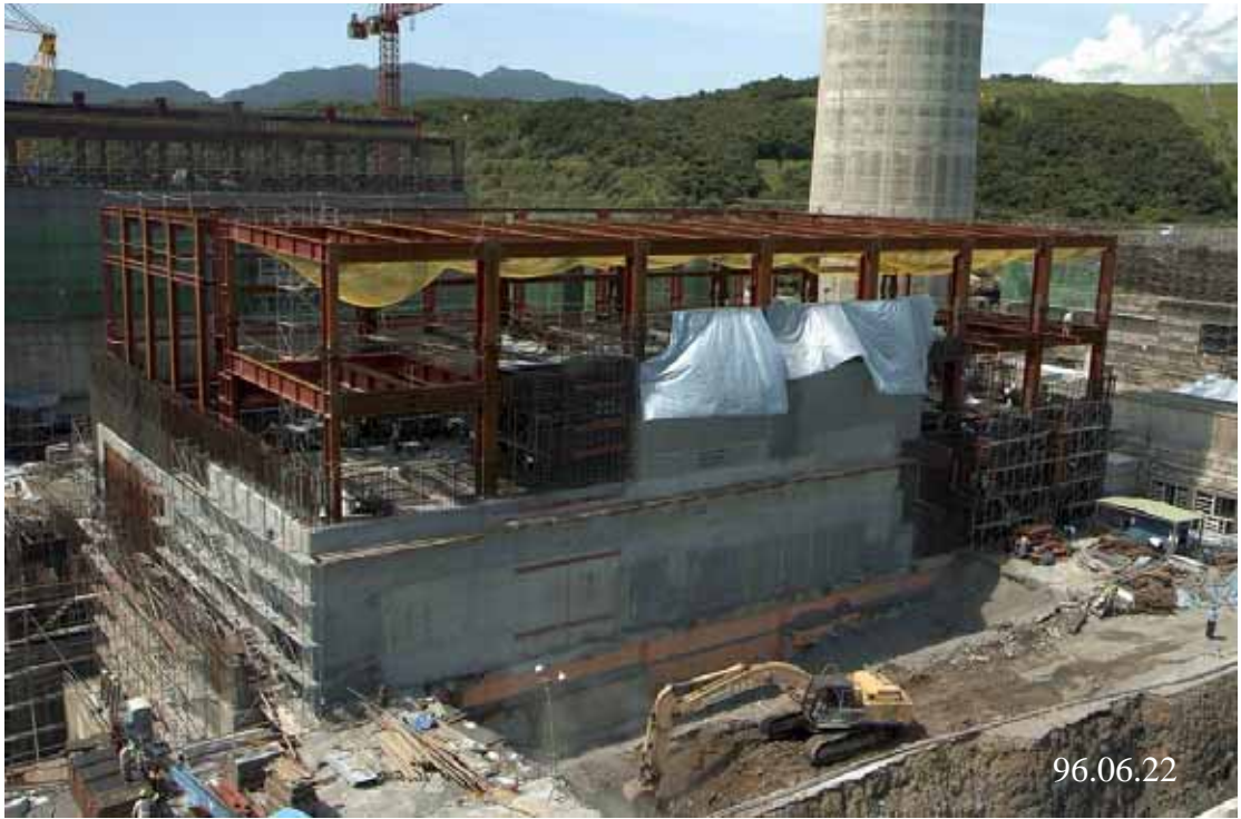
圖七：輔助用過燃料廠房施工現況圖景
