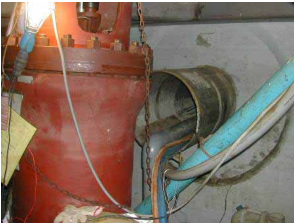
圖八 餘熱移除系統之配管作業尚未完成
