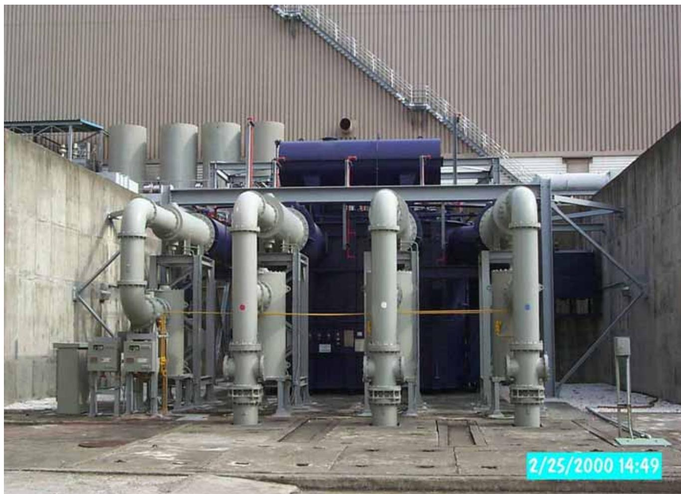
圖 1 345 kV 起動變壓器外觀(MC-X01)
