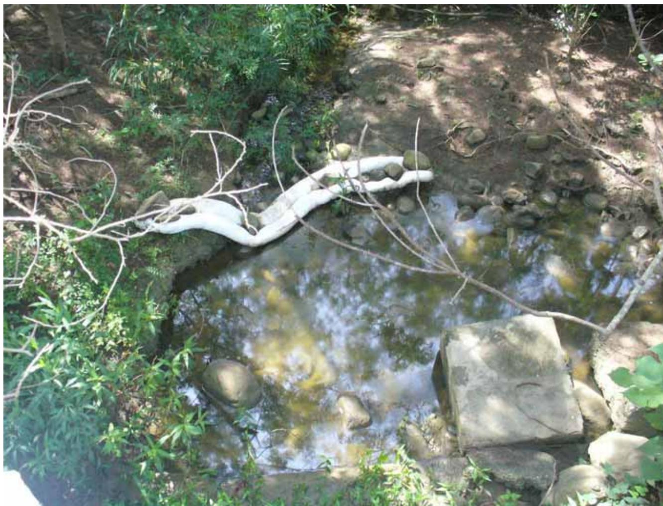
圖 6 設置攔油索限制絕緣油外釋
