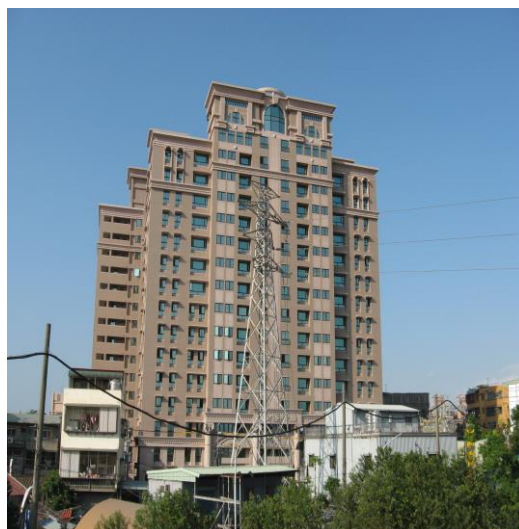
瓊林路社區住戶意見整合順利，於 94.5.10 完成拆除，新建物於 97 年興建完工，為 15 層住宅大廈
