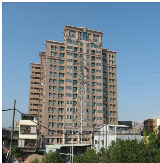
瓊林路社區住戶意見整合順利，於 94.5.10 完成拆除，新建物於 97 年興建完工，為 15 層住宅大廈
